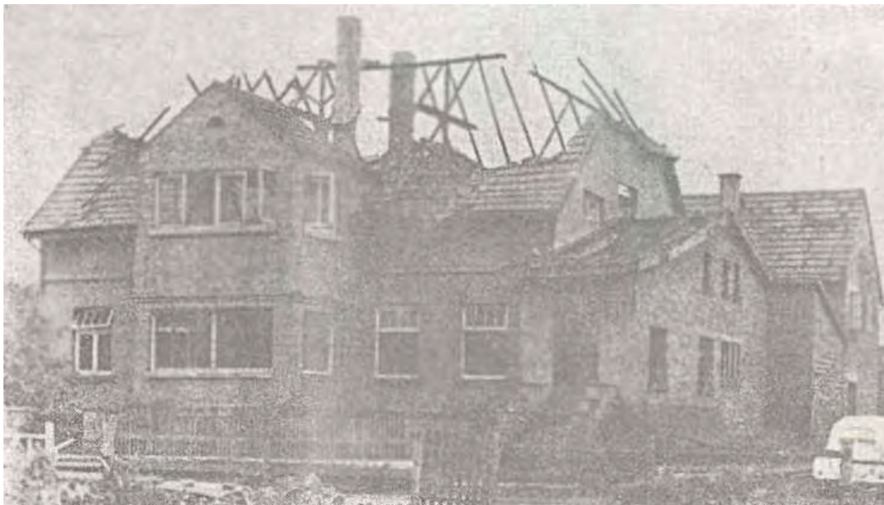
Der Brand begann im Kleiderschrank: Zerstörtes Wehrdensch Wohnhaus
